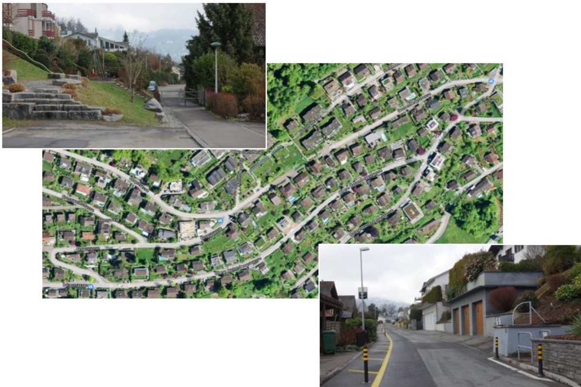
Abbildung 22: Situation Sonnenberg - Dattenberg Oben: Sonnenbergstrasse, unten: Obere Dattenbergstrasse
