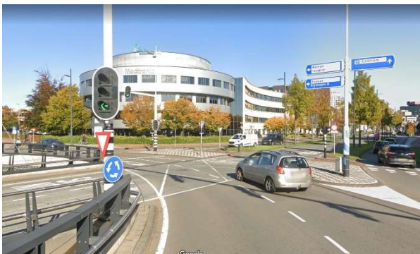
Abbildung 15: Noordbrabant in Eindhoven (NL): Kreiseldurchschneidende Busstrasse (Quelle: Google Street View)
