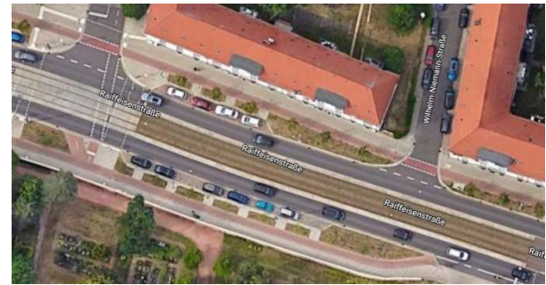
Abbildung 23: Partiiell begrüntes Tramtrasse, Raiffeisenstrasse Magdeburg (DE; Quelle: Google Maps)
