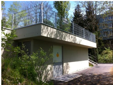
Gleichrichterstation Giseli, Luzern
