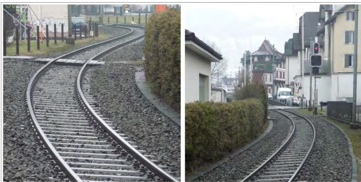
Abbildung 08-08 a: Fotos Stans „Turmmatt“ (Teil 1). S-Kurve in der „Turmmatt“ (links); Blick gegen die Einfahrt in den Bahnhof Stans.
