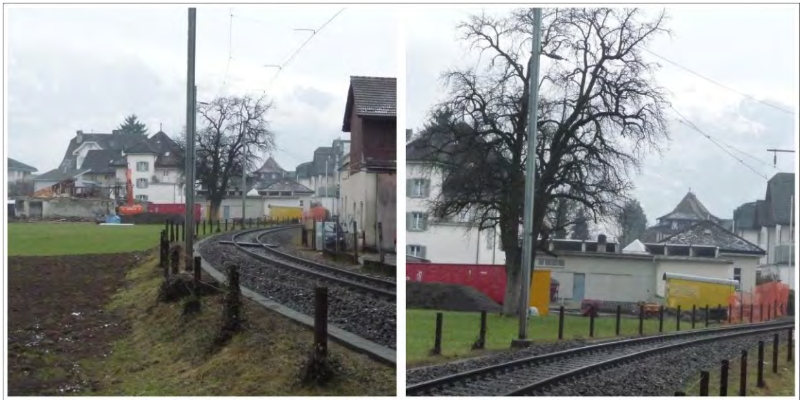
Abbildung 08-08 b: Fotos Stans „Turmmatt“ (Teil 2). Wohnhäuser und Nebenbauten in der „Turmmatt“. Blick von der Stansstaderstrasse. Abbrucharbeiten im Februar 2011.
