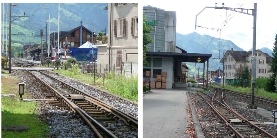
Abbildung 13-03: Blick von der Landi (Gebäude auf der linken Seite, nicht im Bild) Richtung Bahnhof sarnen. Klar erkennbar das Gleis des Perrons 1 (Bild links). Anschlussgleis der Landi mit dem Gebäude der Landi (Bild rechts).
