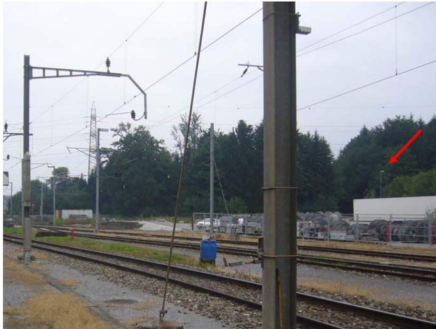
Abbildung 13: Querung des Lagers Zur besseren Erkennbarkeit ist das Kandelaber der bestehenden Strasse mit einem roten Pfeil markiert
