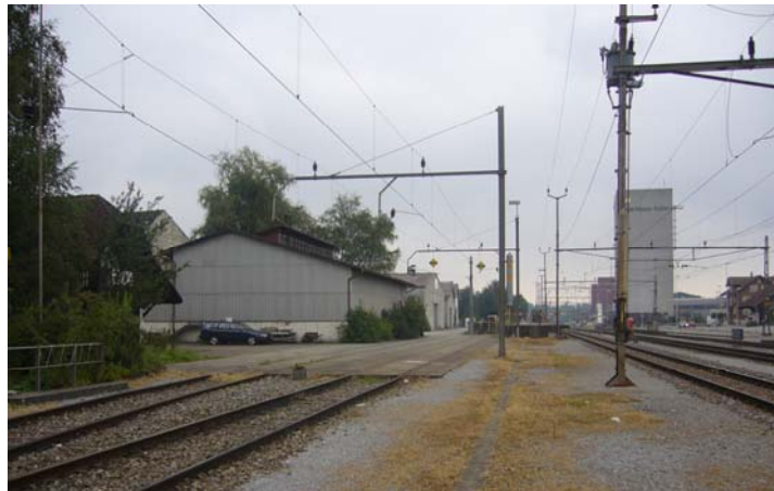
Abbildung 11: Ende der befestigten Oberfläche und Fahrleitungen
