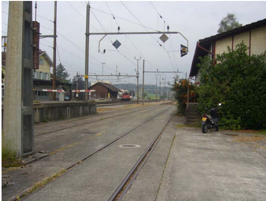
Abbildung 10: Engstelle mit Abspannung der Fahrleitung
